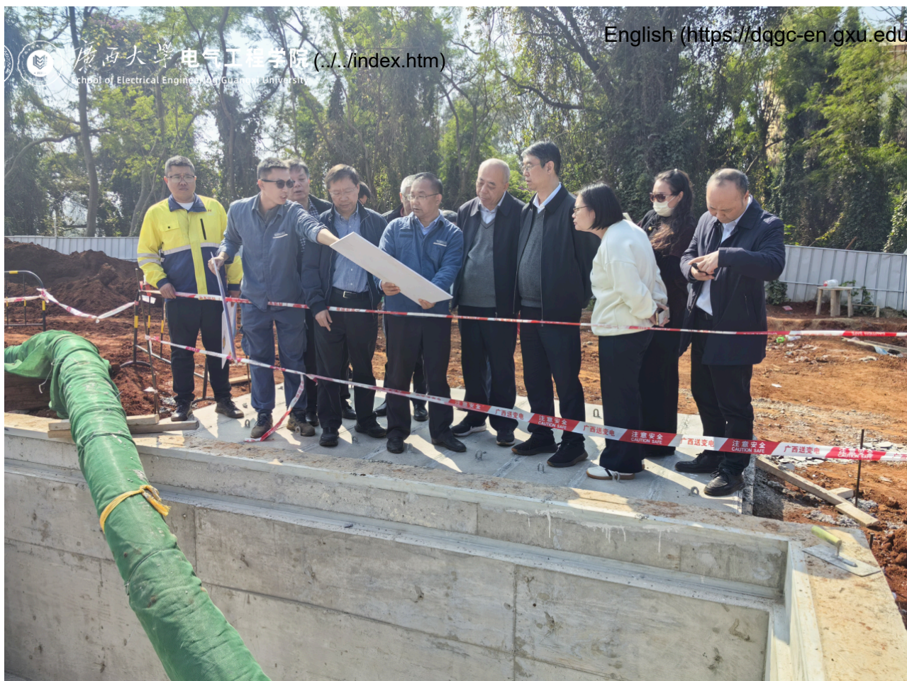
专家在考察涠洲岛电力跨海联网工程的海底电缆施工现场
